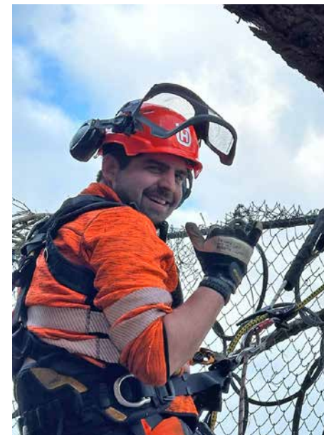
Tino Michel bei Steinschlagsicherungsarbeiten
